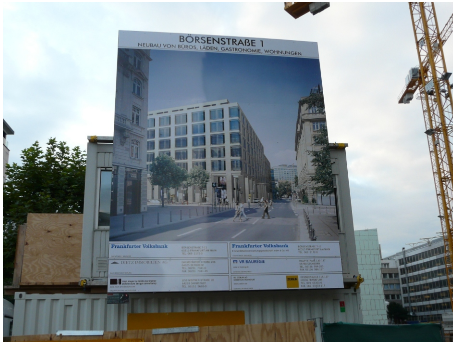
500 x 600 cm großes Bauschild mit Alu-Konstruktion an Container montiert
